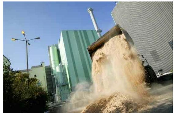
Das Biomassekraftwerk ist mit einem modernen Wirbelschichtkessel ausgestattet, der bei den geplanten 8.000 Betriebsstunden pro Jahr rund 115.000 Tonnen Biomasse nutzen wird. Die Anlieferung der Biomasse konnte mit langfristigen Verträgen gesichert werden:
